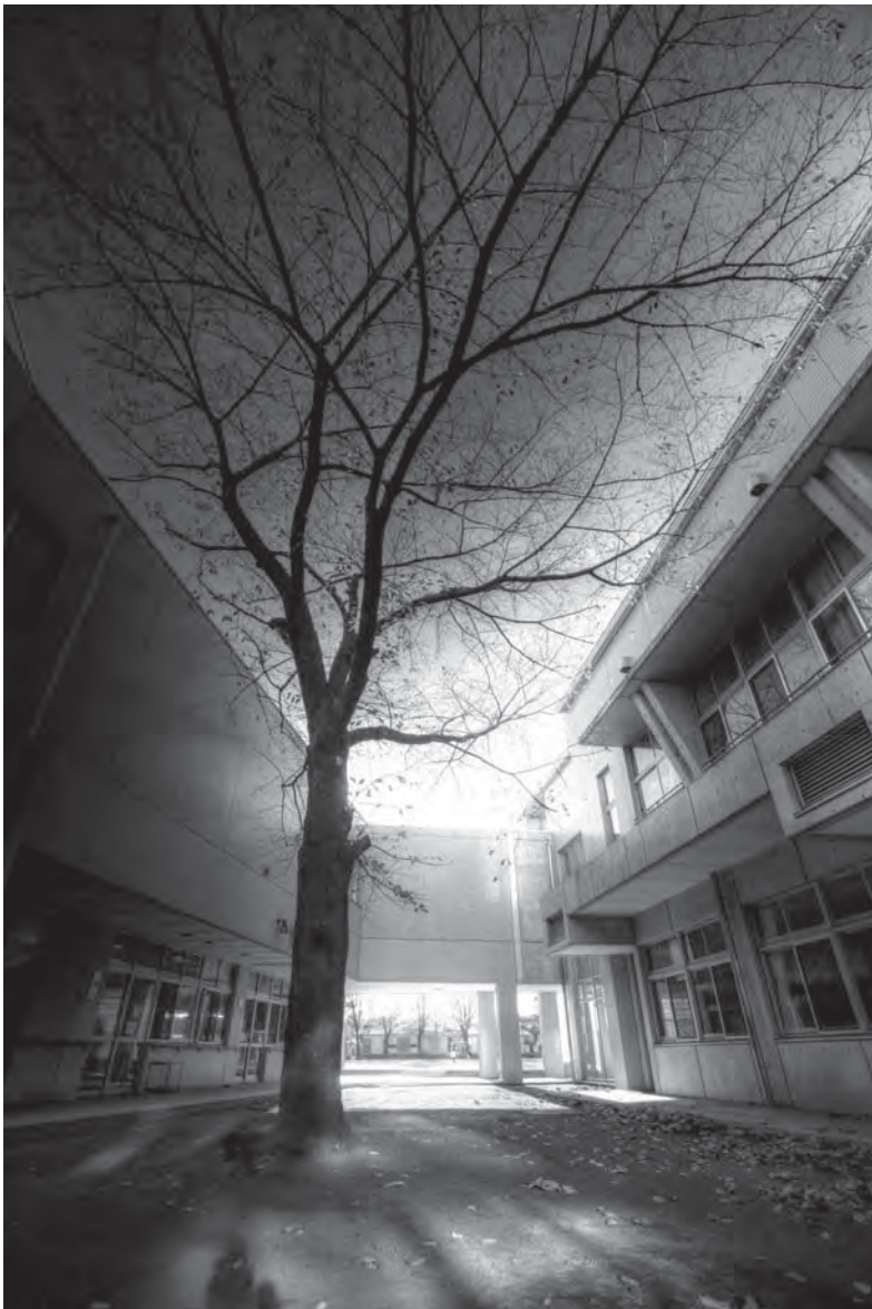
小学校中央棟と北棟の間、さくら大通りからグラウンドを臨む
